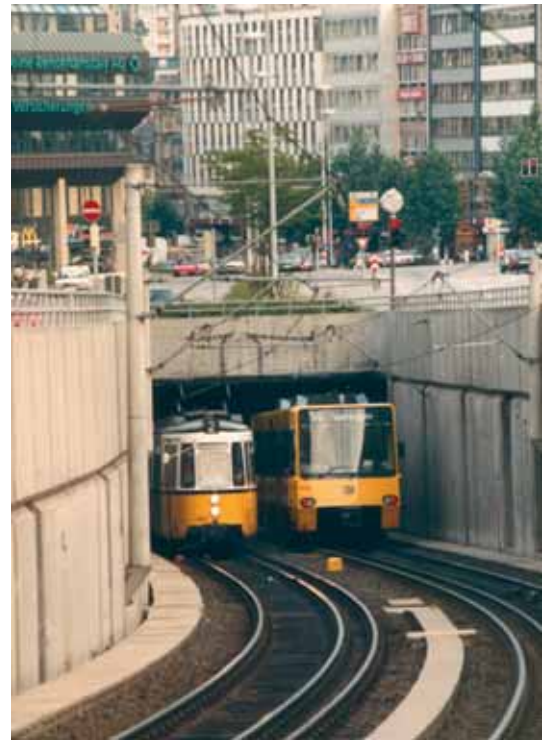
Σύγχρονο τραμ και ελαφρύ μετρό σε τμηματικά υπογειοποιημένο διάδρομο στη Στουτγκάρδη
